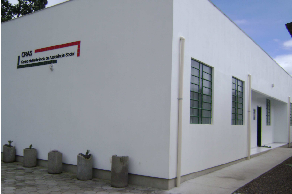
Fotografia 1 - Centro de Referência de Assistência Social de Forquilha/SC
